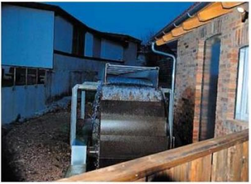
Das Wasser fließt aus der Grumbach über Rinnen, um das Gefälle zu erhöhen, in die Schaufeln des Wasserrades aus Stahl. Fotos (2): Udo Weiblich
